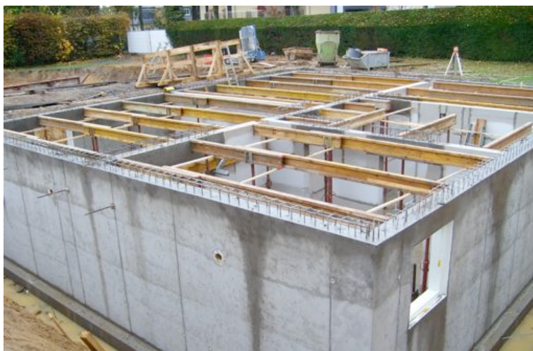
Kellergeschoss WU Beton
